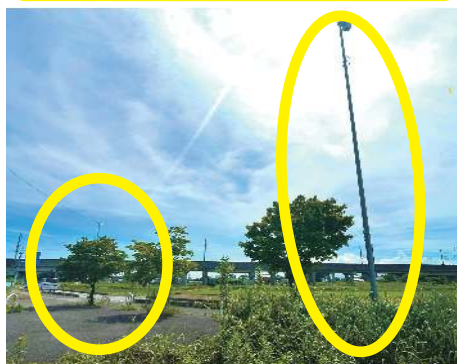
安養寺街灯設置
